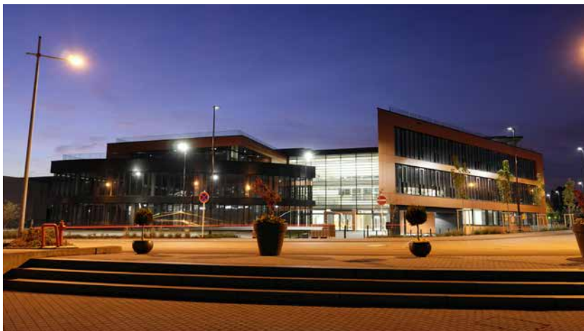
_Beaubourg Atrium Frontansicht
